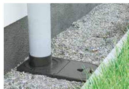
6. Įrenkite paviršiaus dangą. Trapas paruoštas.
